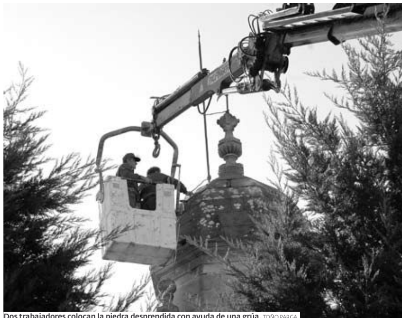
Dos trabajadores colocan la piedra desprendida con ayuda de una grúa. TOÑO PARGA
